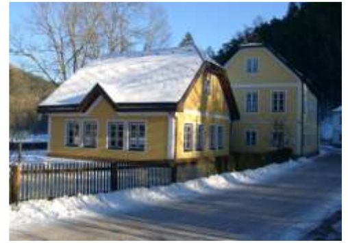
Dritte Kindergartengruppe macht einen Zubau notwendig.
